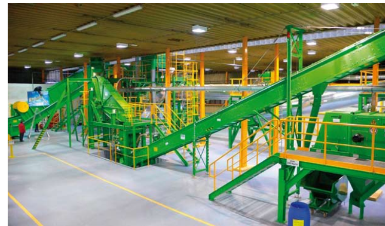
Špeciálna linka zbaví chladničky a mrazničky nebezpečných plynov, ktoré obsahujú.
