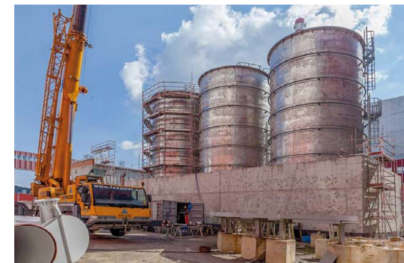
Superhavarijné napájanie – ukončená montáž tretej nádrže.
